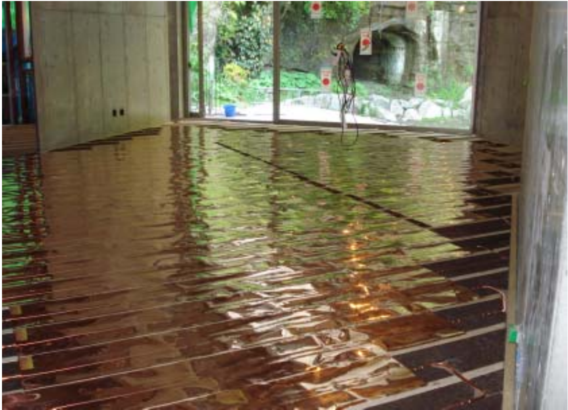
床暖房パネル工事
