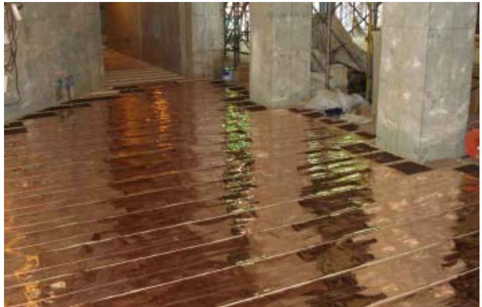
床暖房パネル工事
