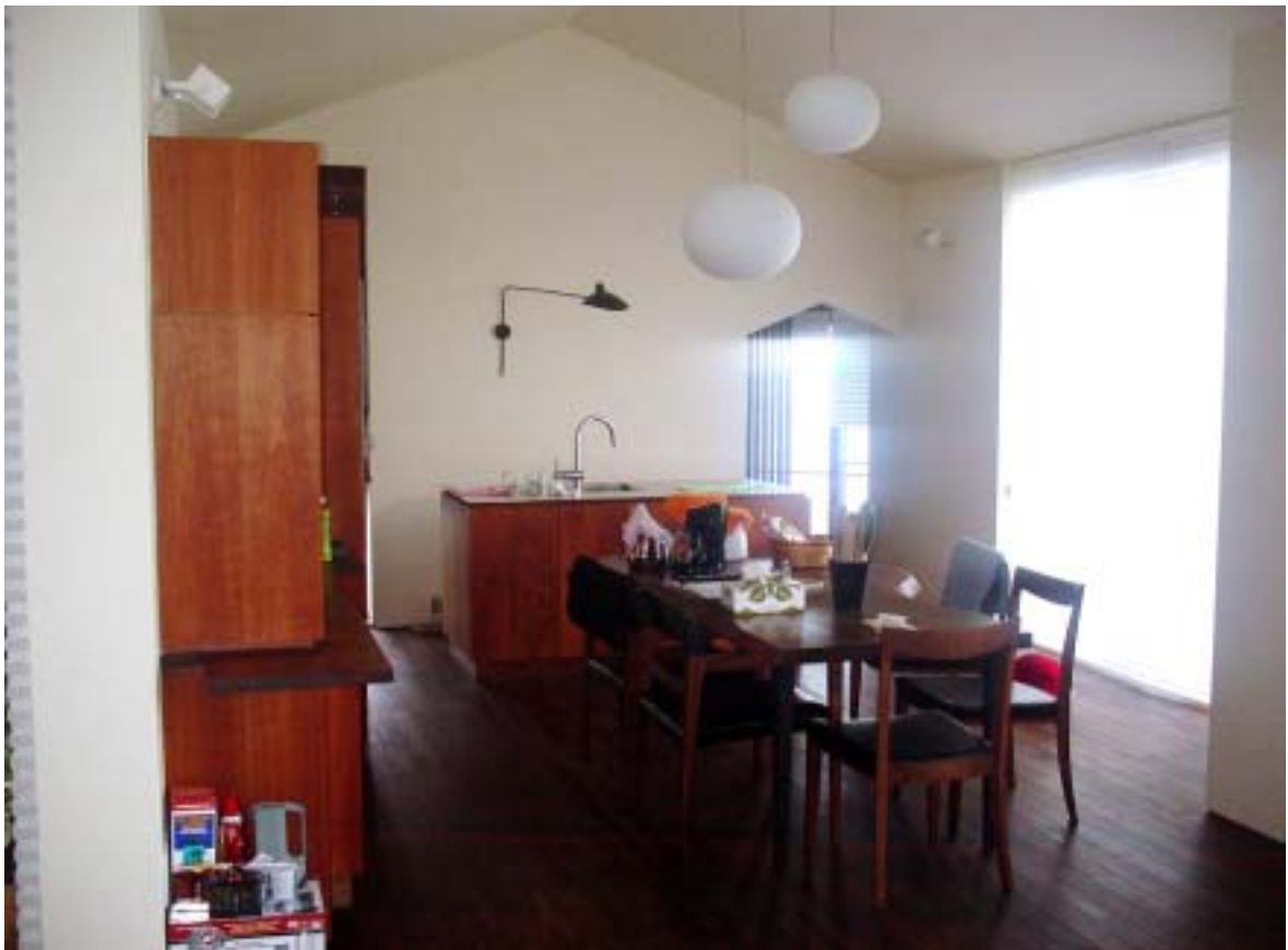
内部完成(仕上げ材:無垢フローリング 厚み15mm)
