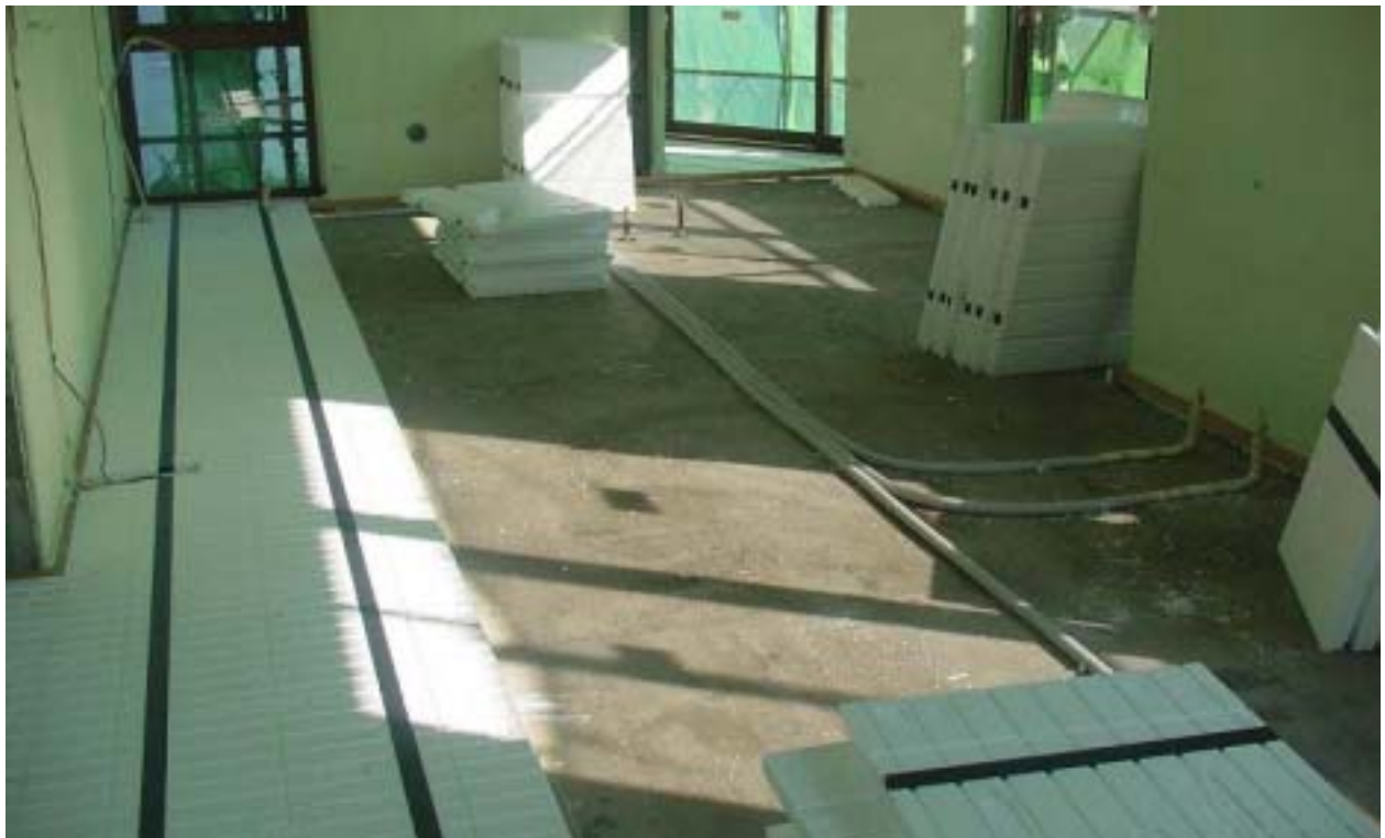
先行配管工事
