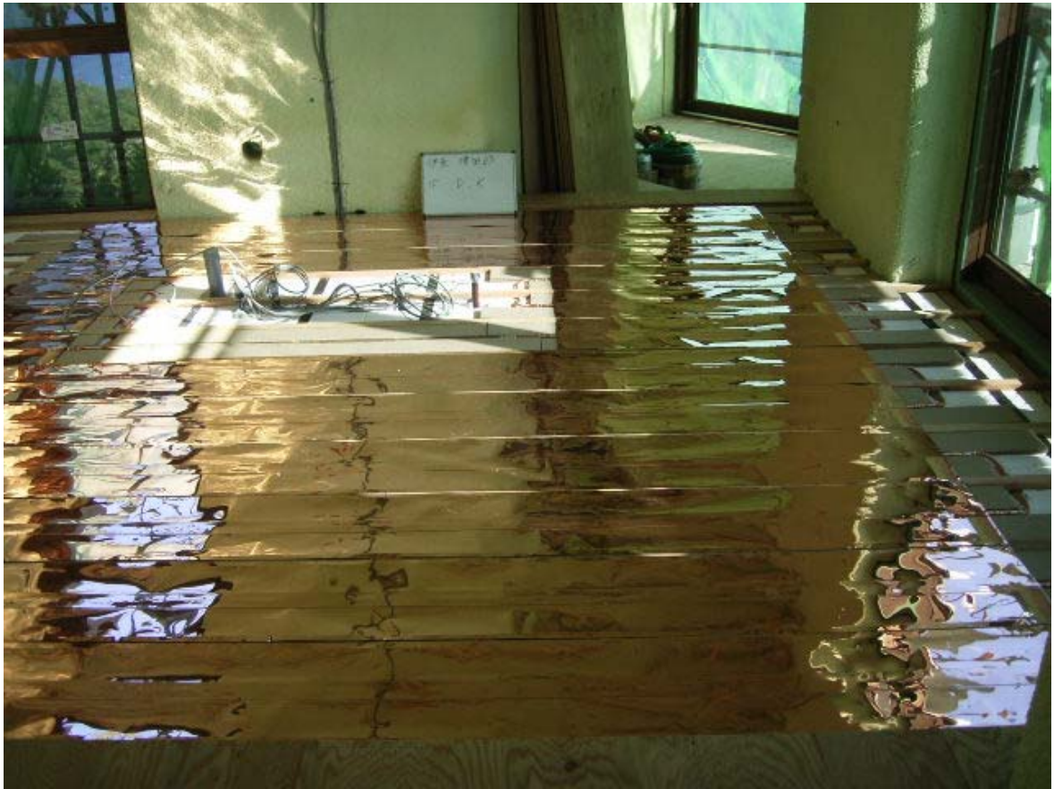
床暖房パネル工事
